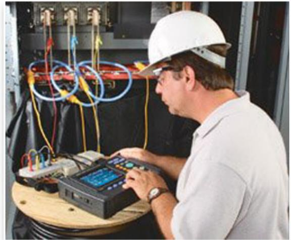
Figura 5 Programación e instalación de un Power Quality Analyzer
