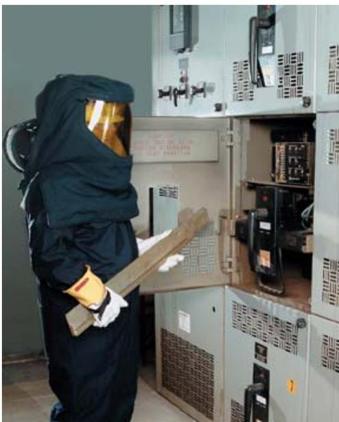
Figura 11 Inspección Eléctrica con protección contra arc flash
