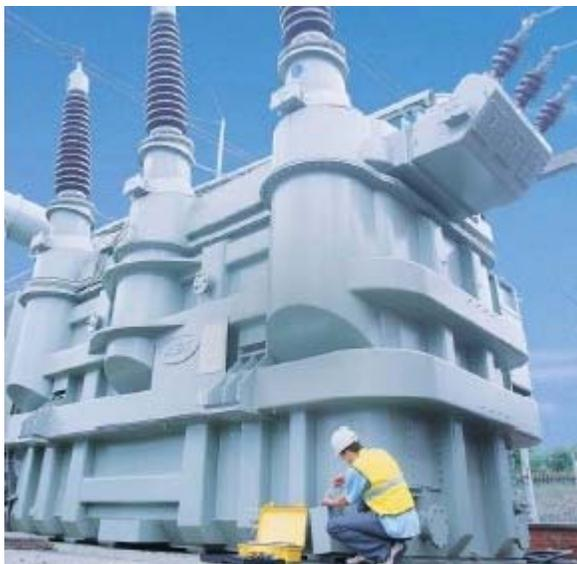
El aceite dieléctrico en los transformadores de potencia realiza dos grandes funciones: Primero, sirve como elemento aislante para poder soportar los altos voltajes que se generan internamente dentro del transformador. Segundo, el aceite mineral tiene la función de servir de elemento trasmisor de calor para poder disipar el calor
